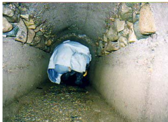
図 2 暗渠の中の様子
