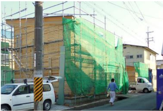
右奥の白い建物が仮礼拝堂で、完成すると集会室・牧師館になります。
