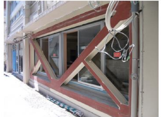
1階の、もと幼稚園の廊下だったところに耐震補強の工事が行われているところです。
